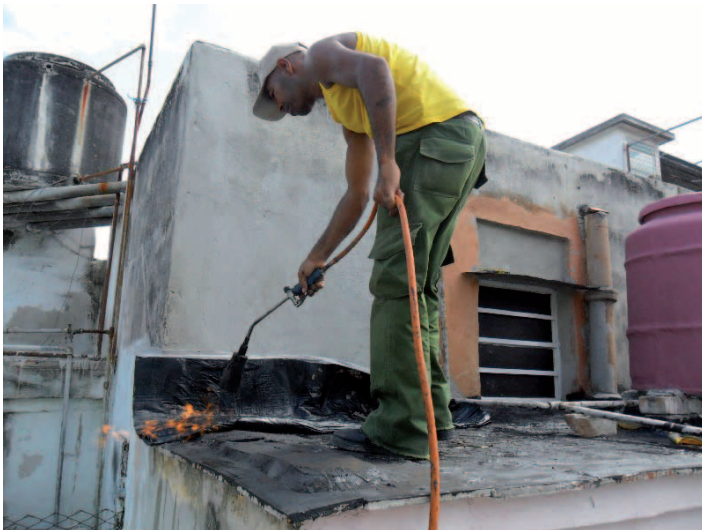
Dichtungsarbeiten am Dach
