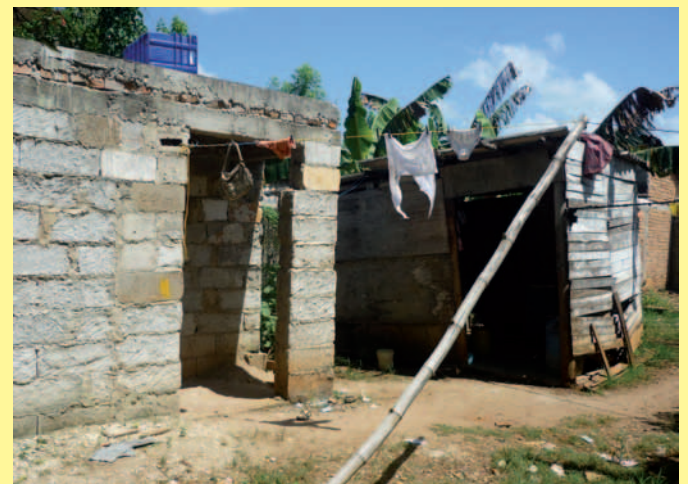
Links der Rohbau des neuen Hauses.
