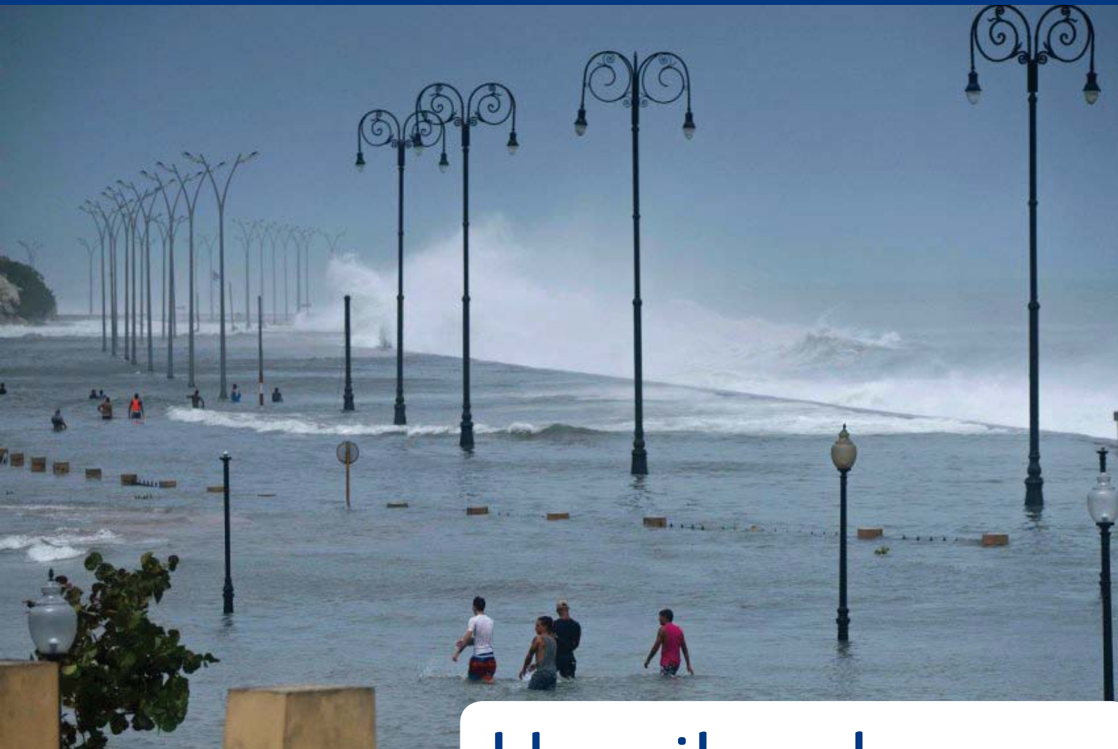
Hurrikan Irma ließ das Wasser weit mehr als 500 Meter ins Stadtzentrum von vordringen.
